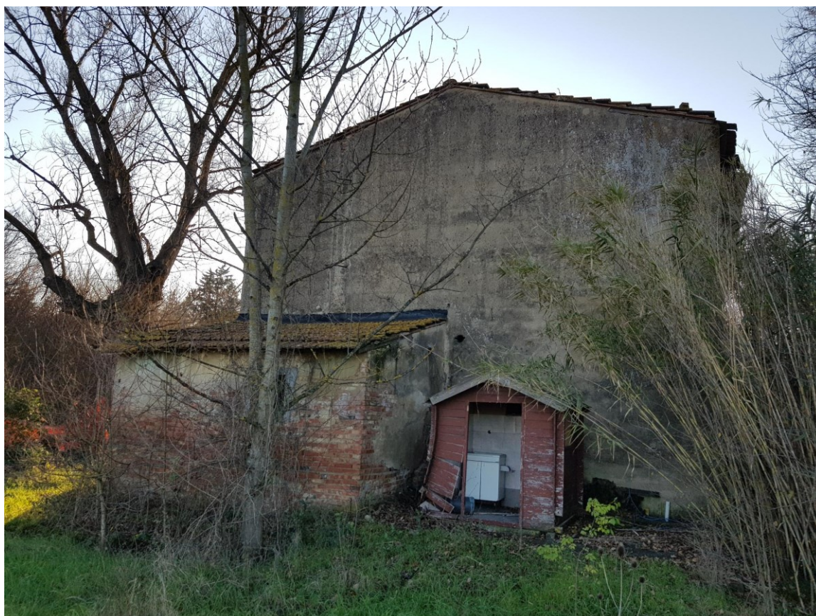
Foto prospetto laterale destro
