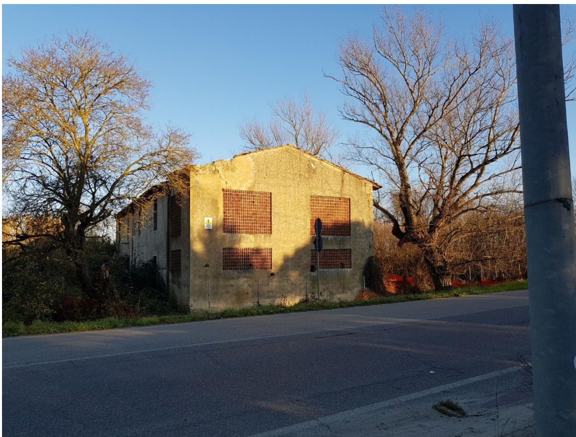
Foto prospetto laterale sinistro – Via del Castelluccio
