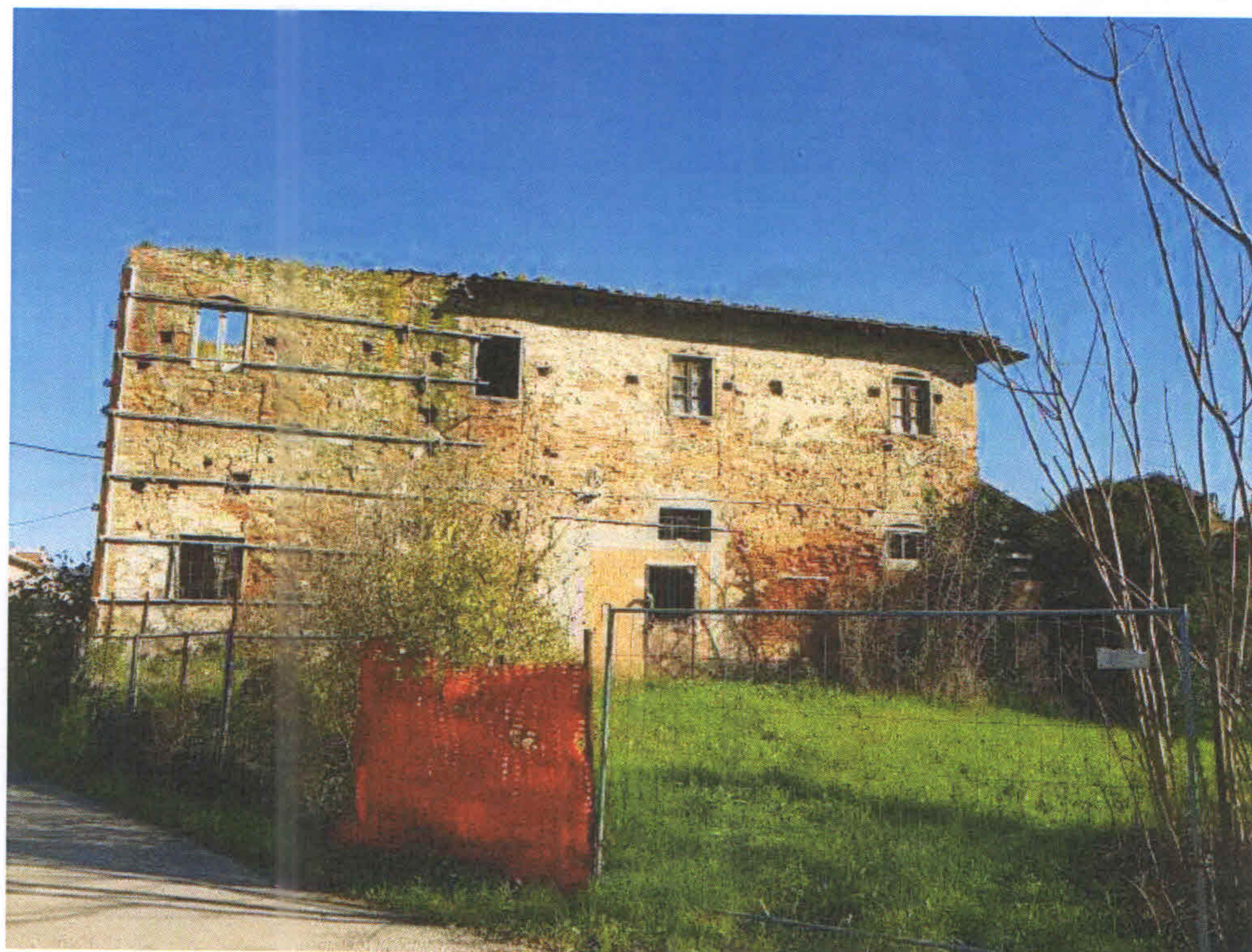
Foto n.1 - Vista prospetto frontale
